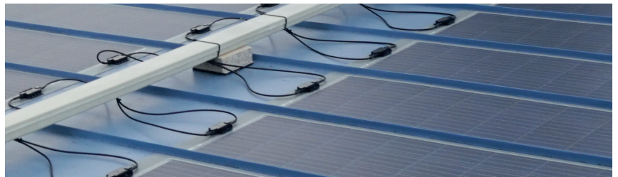
Abb. 10: Beispiel eines von der Dachbahn distanzierten Kabelkanals
